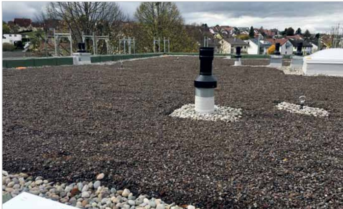
Flachdach Wohngebäude in Kusterdingen
